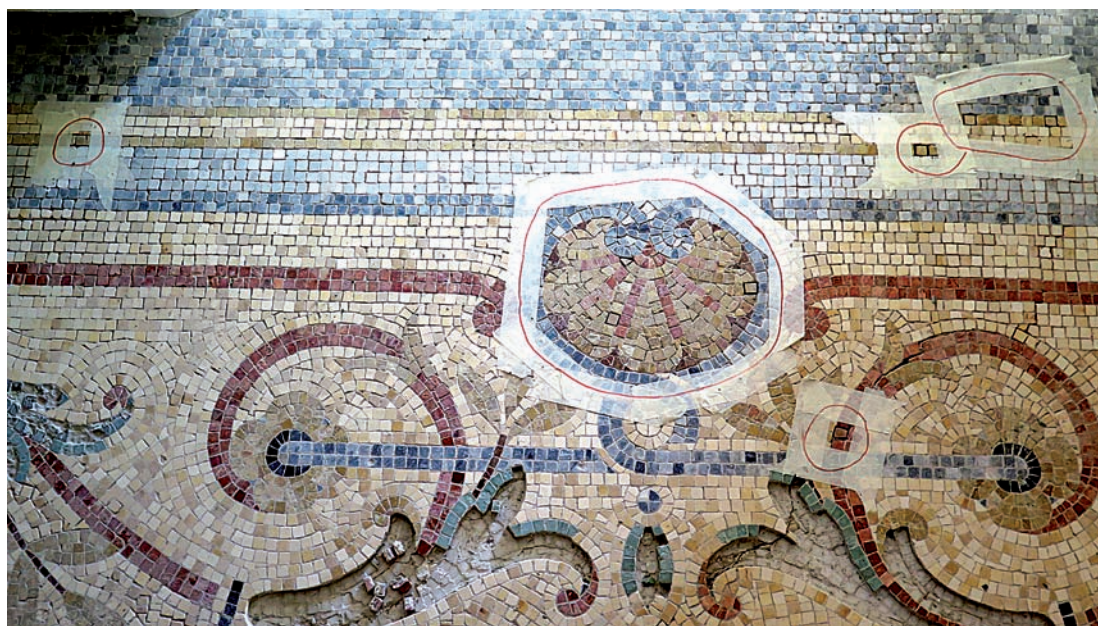
Différentes vues du travail de Rachel Casimir, avec notamment l'annotation des tesselles à remplacer ou qui ont été remplacées avant le jointement. On distingue également l'empreinte des tesselles sur la chape d'origine.
